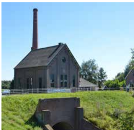
Het stoomgemaal functioneert als onderdeel van het recreatief knooppunt.
