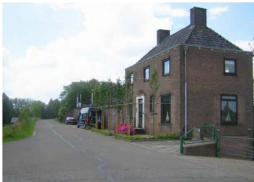
Opvallende bebouwing accentueert de kruising op de dijk.
