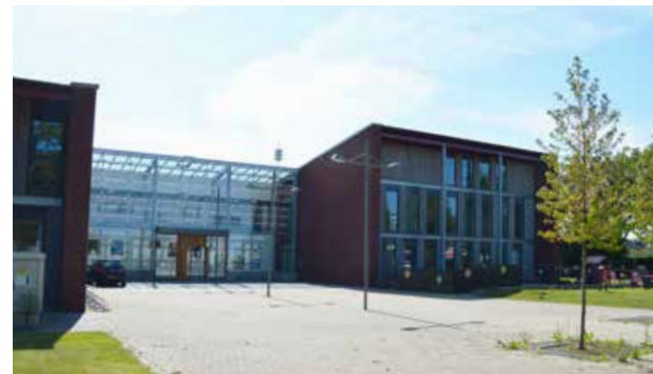
Het kenmerkende gebouw van de multifunctionele accommodatie
