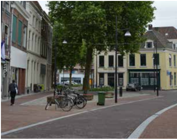
Een eenvoudig profiel zorgt voor rust bij gevarieerde bebouwing.
